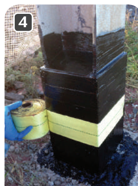
4 Envuelto con Kevlar® y resina epóxica
