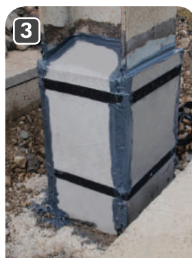
3 Aplicación de los insertos metálicos
