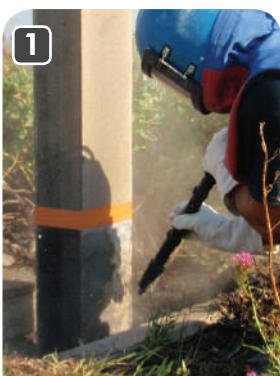
1 Preparación de la superficie Sa2½ / Si3 y rugosidad Rz > 60 µm
